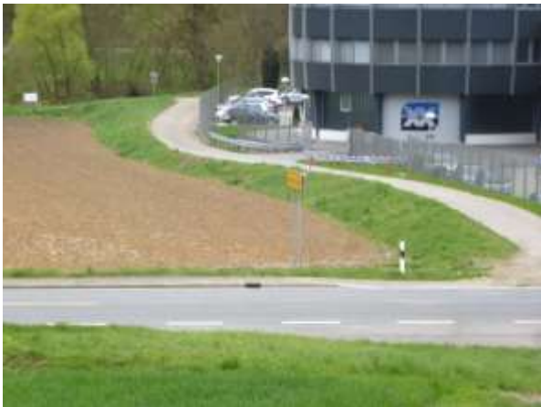
Abb. 8: Blick auf die Böschung des Wirtschaftsweges im Westen des Plangebiets
