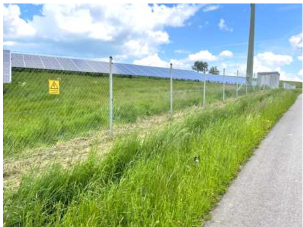
Abb. 21: Nördliches Untersuchungsgebiet mit bestehender PV-Anlage und Weg mit Bankett.
