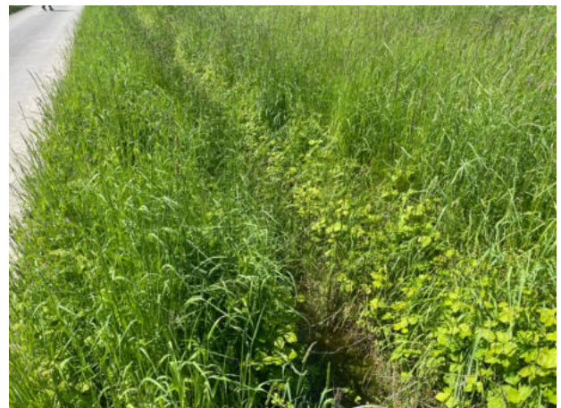
Abb. 21: Entwässerungsgraben zwischen Plangebiet und südlich verlaufendem Feldweg.
