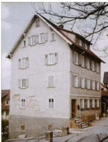
Lehrerwohnhaus vor dem Oberen Tor
